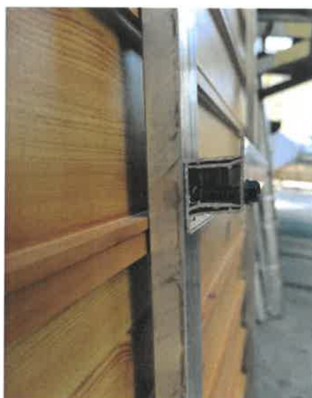
Pohled na průřez horizontálního hliníkového profilu
